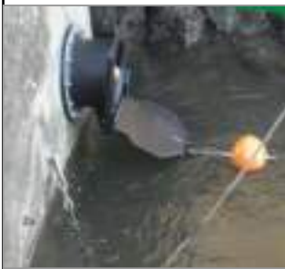
Valvola a membrana WS
